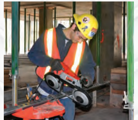
Le confrère Martin Lefebvre, apprenti de 1re période – chantier du nouveau CHUM.
