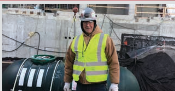
Toute une équipe de délégués est à l'œuvre sur les chantiers du Local 144. Nous vous présentons l'un d'eux, le confrère Jacques Bourdages sur le chantier du Complexe des sciences.
